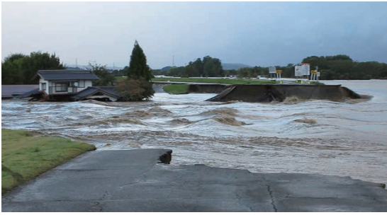
決壊した千曲川の堤防（2019年10月）
